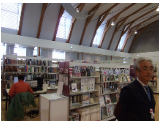
図書館内部 木材の集合材の張りがむき出し
