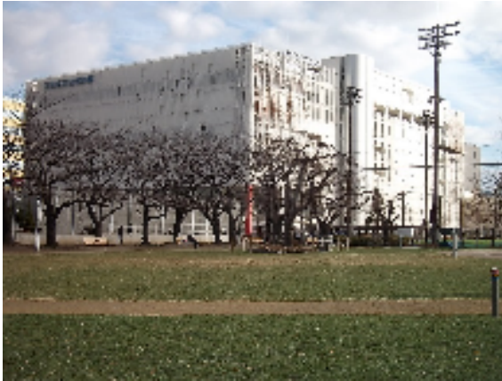
体育館の外観
