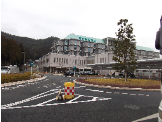
病院正面から
